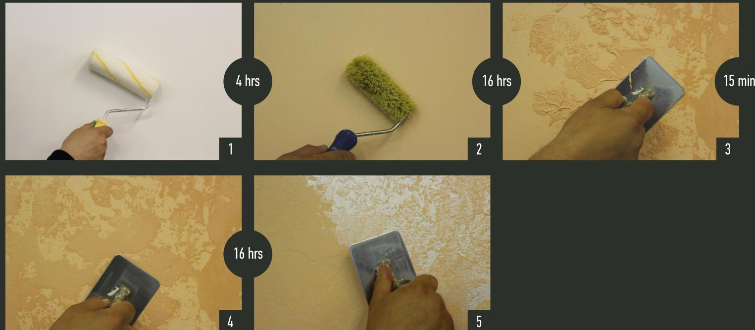
1. Загрунтуйте поверхность материалом «Унигрунт А» / Подгответе повърхността с материал «Унигрунт А» / Apply a coat of “Unigrunt A”
